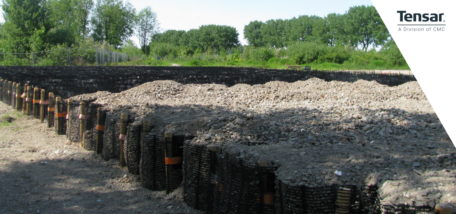
TensorTech® Stratum® bestaande uit vormvaste Tensor® uniaxiale RE-geogrids en de Tensor® InterAx® geogrids
